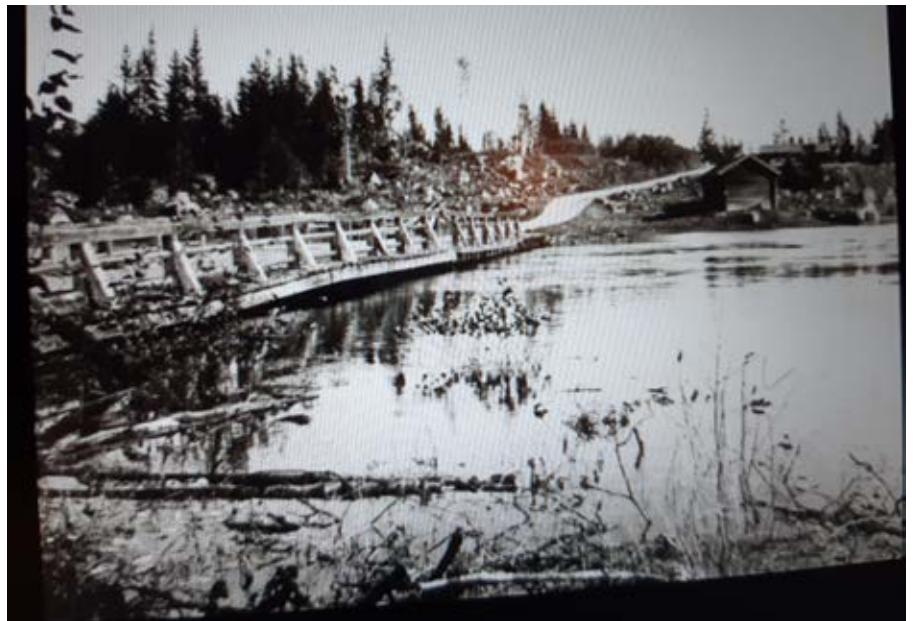
Den västra bron reparerad.
